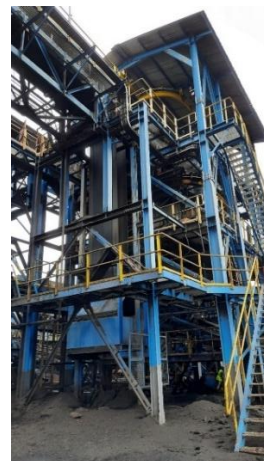
Gambar 1. Gedung rangka baja 3 lantai yang berfungsi sebagai bangunan crusher batu bara
